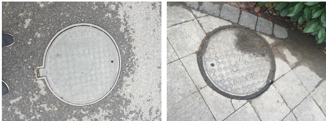
现状雨污水管道
