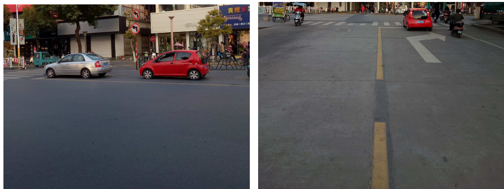
人民路“T”字交叉
