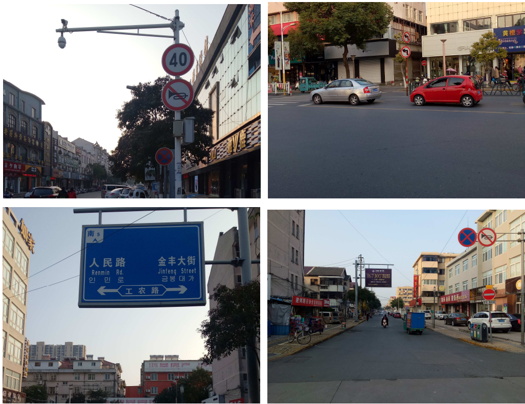
沿线交通安全设施使用状况
